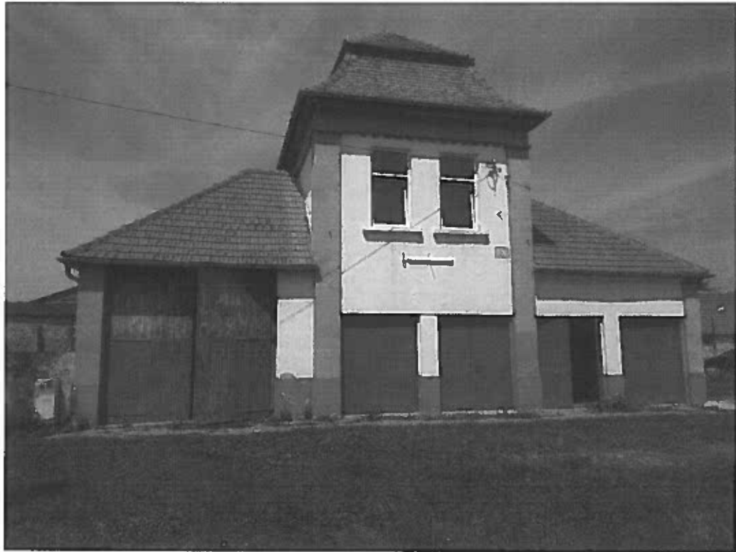
VEDERE SPRE STRADA A CONSTRUCTIEI
